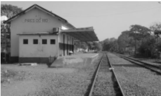
Estação ferroviária desativada, em Pires do Rio
